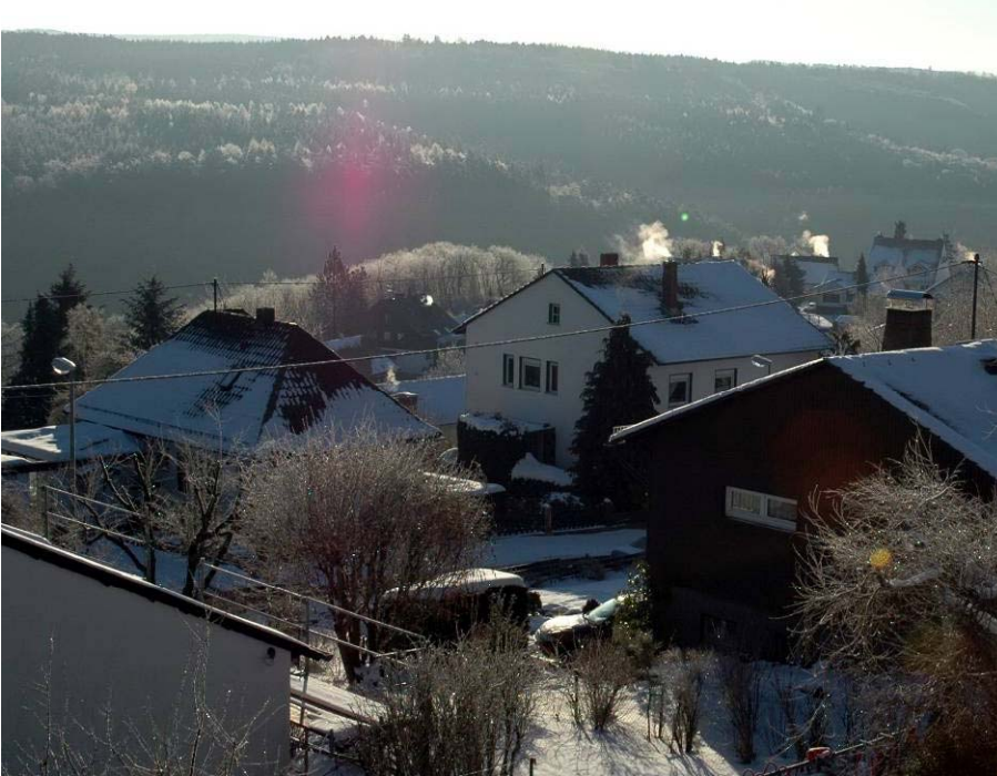
Bild 1: deutlich sichtbare Mängel an der Dämmung der Dächer, erkennbar an den schneefreien Dachflächen
